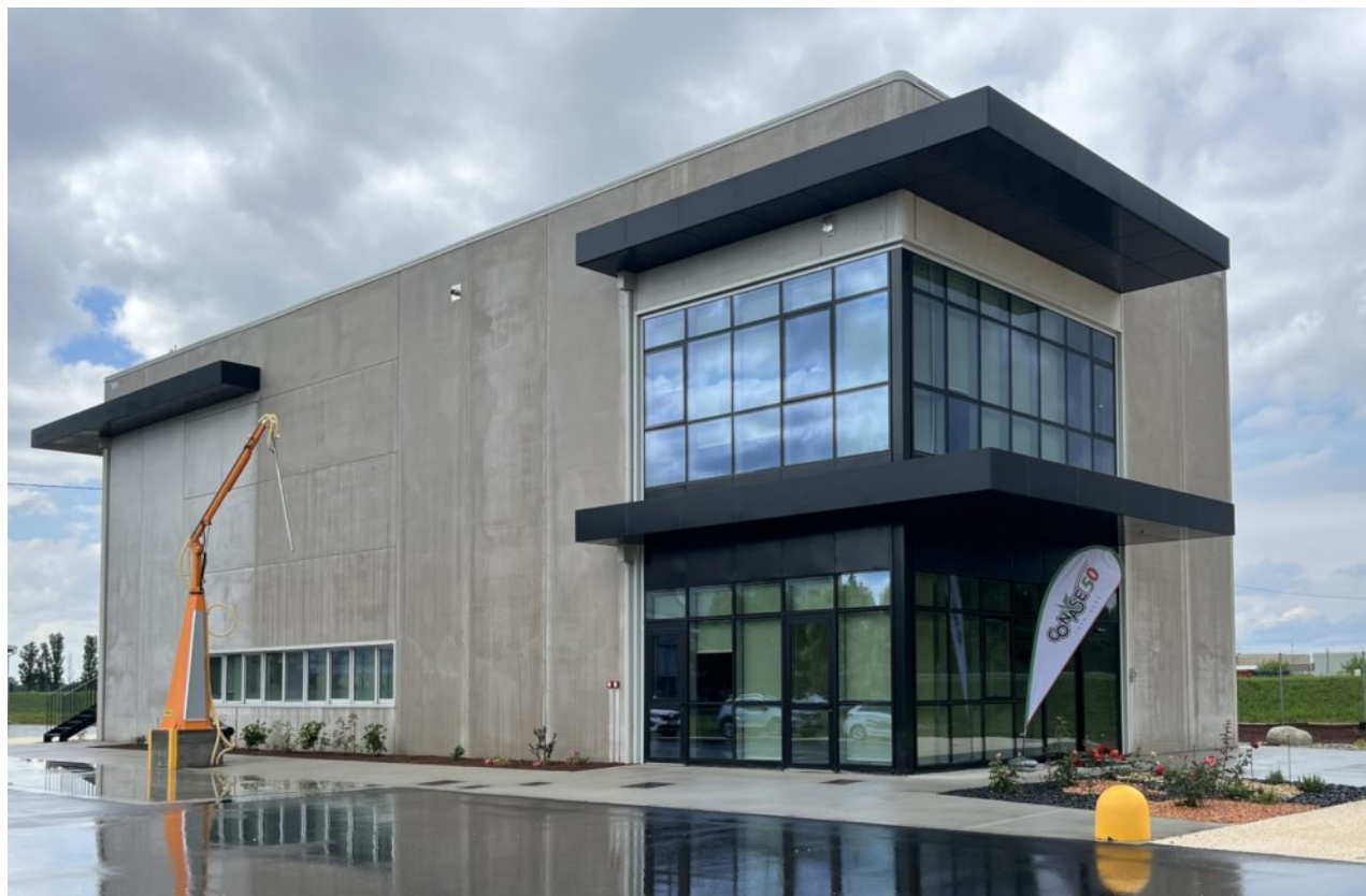
La nuova palazzina che ospiterà gli uffici del Conase.
